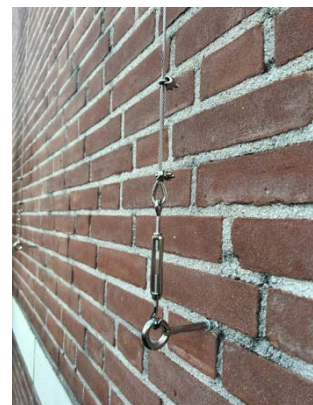
Figuur 4 Oogbout icm draadspanner
