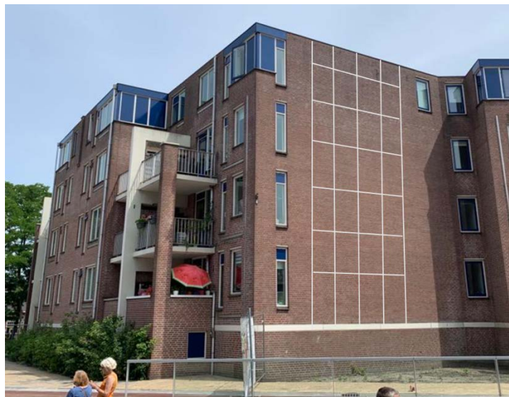
Figuur 2 Muur Zuid West kabelsysteem
