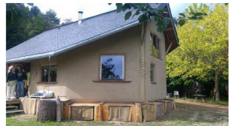
Een klein zeshoekig stro-leem huis van 25m2 met ongelijk dak isoleert vele malen beter dan gangbare isolatiematerialen
